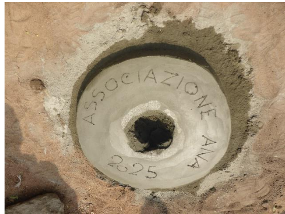
Posa della prima pietra dell'edificio scolastico a Duduzemé
