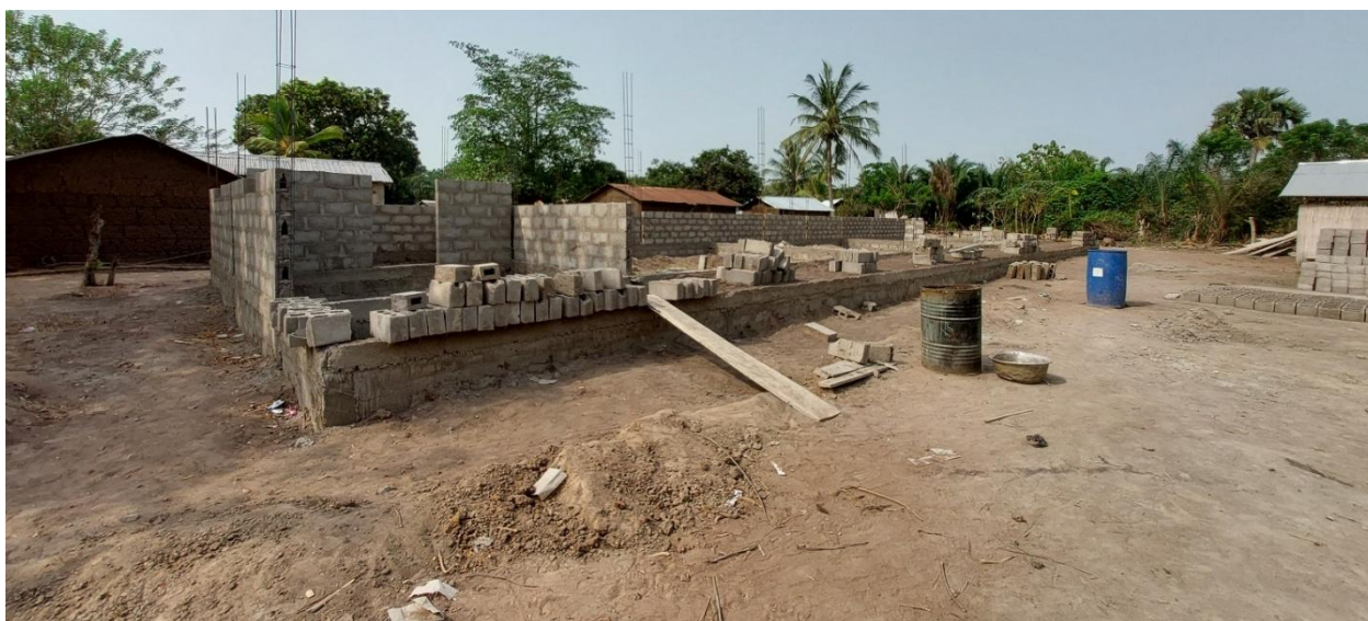
Nuovo edificio scolastico in costruzione a Gapé-Zewé
